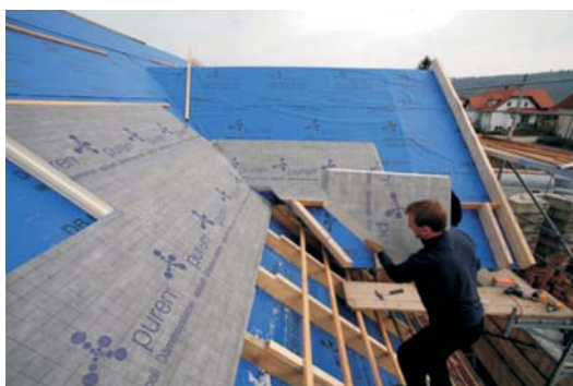
Obr.41 - montáž úžlabí
