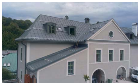
Obr.42 - montáž plechové střechy - titanžinek
