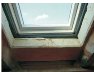
Obr.22 - pracovní otvor pro střešní okno
