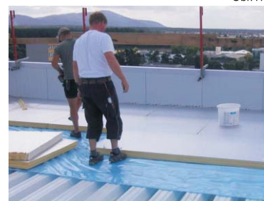
pokládka na PE fólii Obr.18
