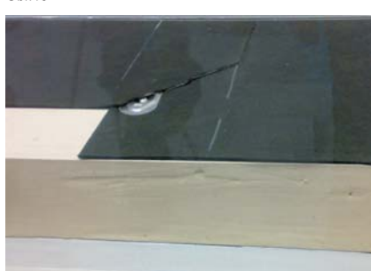
přesah dvou vrstev hydroizolace+kotva
