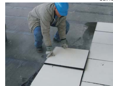
lepení do asfaltu Obr.20
