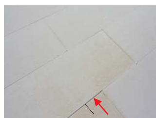
Příklad spárové netěsnosti
