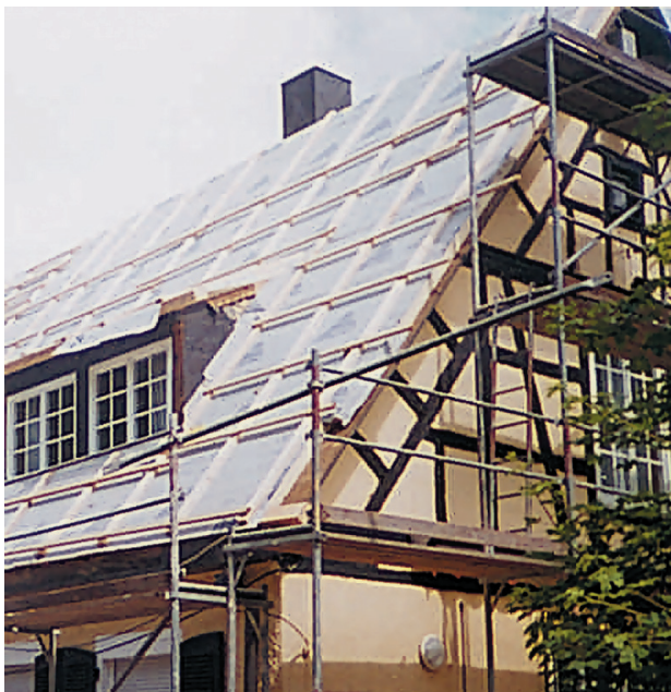
Rekonstrukce střechy pomocí systému izolace Puren - celoplošně bez tepelných mostů.
