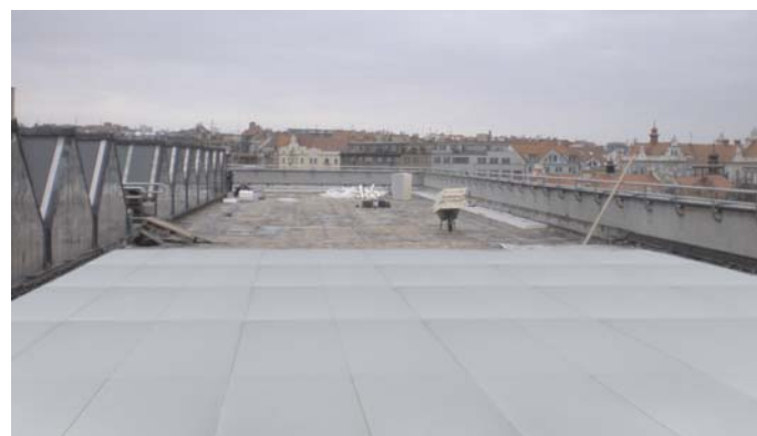
Pokládka izolace na střechu Veletržního paláce.
